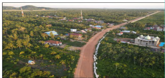
Pekerjaan Timbunan dan Box Culvert
